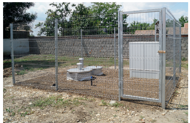
Kompaktschacht und Steuerschrank nach Montage
